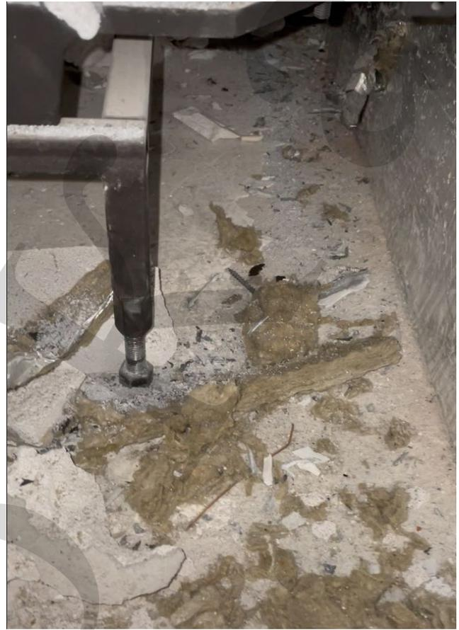
2. Фото для пункта №2 . Разрыв тепловой отсекки , фото через верхнюю вент решетку , выше канал шахты, разрывы минеральной ваты .
